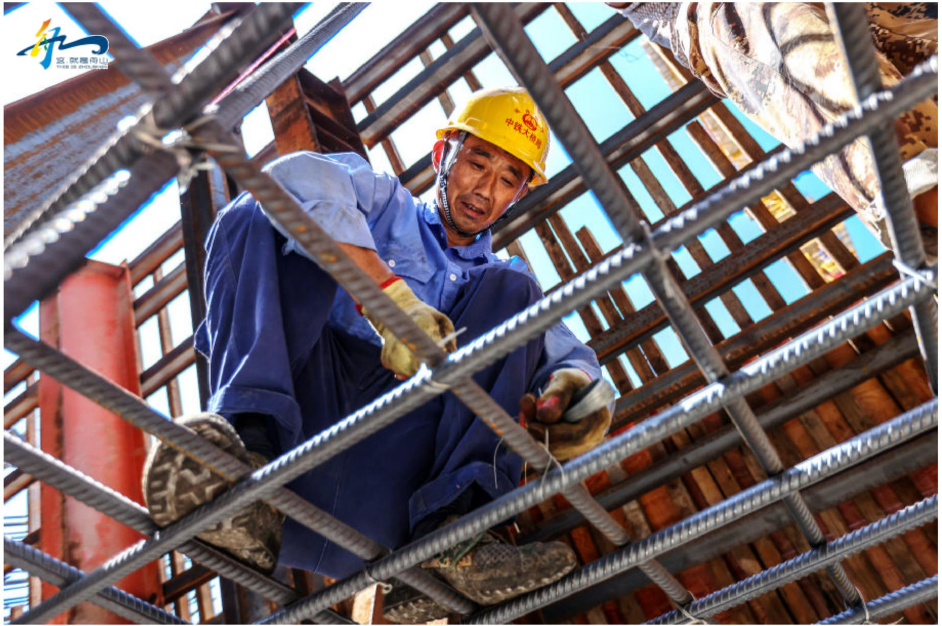
甬舟铁路西垵门公铁两用大桥锚碇建设现场，一位工人正在酷暑中进行钢筋对接、绑扎等施工 图/姚峰
