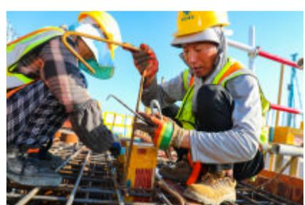
金塘新材料项目施工现场，工人们正在烈日下绑扎钢筋 图/张磊
