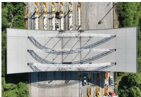
无人机巡检舟山跨海大桥
