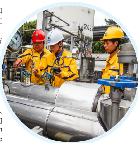
▲对天然气场站开展城镇燃气设施安全检查。
