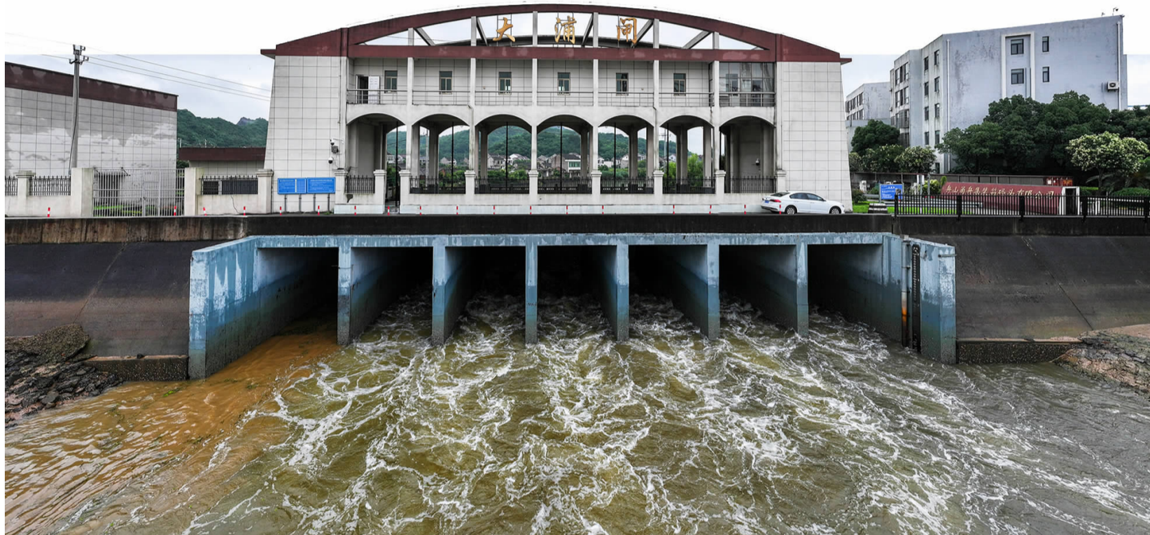
昨天傍晚,定海区金塘镇大浦闸开闸排水。堤内河水通过七孔闸奔腾入海,以保辖区安全。通讯员 姚峰 摄
