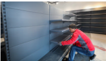
工人正在配送中心安装货架 摄影 记者 张磊
