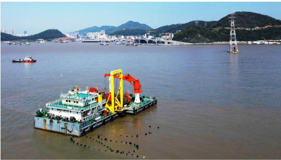
技术代替了传统人工开挖、人工冲埋模式，不仅提高了施工效率，还从根本上解决了海缆登陆埋深不足导致的外破问题，既保护了自然生
