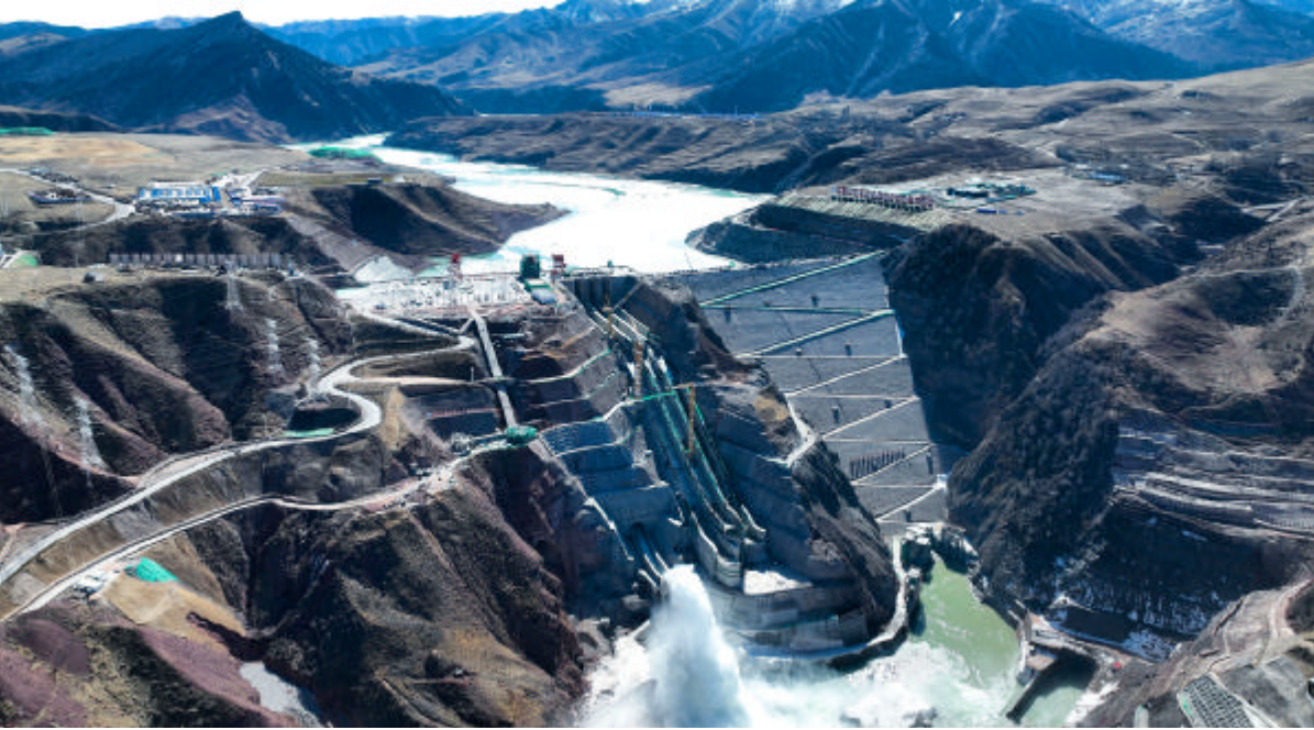
这是4月1日拍摄的玛尔挡水电站(无人机照片) 新华社记者 张龙 摄
