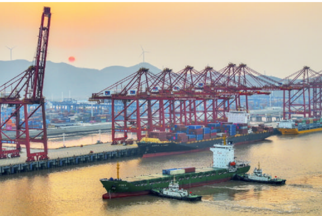
宁波舟山港金塘港区码头作业繁忙（2024年2月11日摄，无人机照片） 新华社 发（姚峰 摄）
