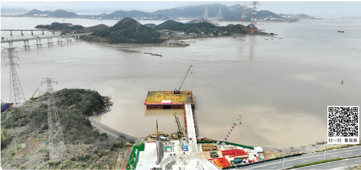
图为96米长施工栈桥和面积3600平方米的海上主墩钻孔平台
