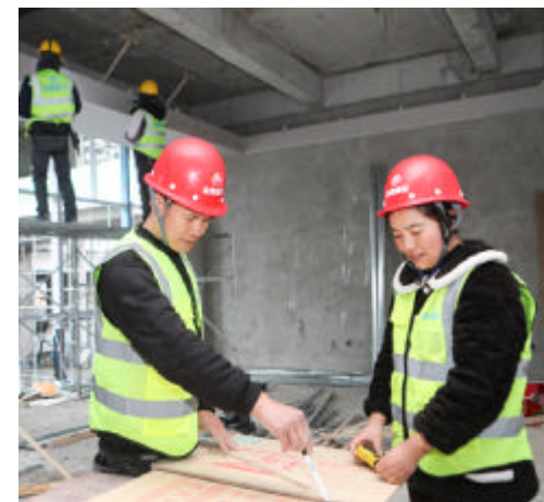
进入3月,东港新建小学项目现场工人全面到岗,开始进入繁忙的室内装修阶段 图/罗沛文
