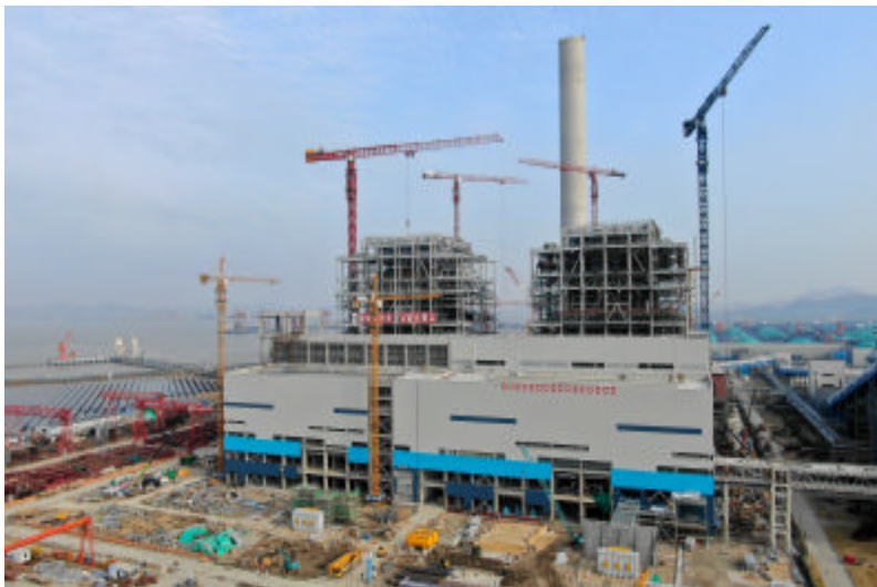
进入3月,位于六横的浙能六横电厂开足马力加快推进项目建设,力争年中首台机组并网发电 图/盛锡浩
