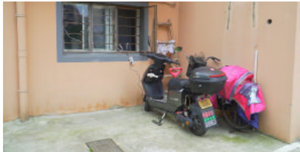
定海桔园新村南区,电动自行车私拉乱接电线充电
