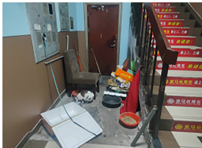
火灾隐患： 一楼楼梯间堆放杂物
