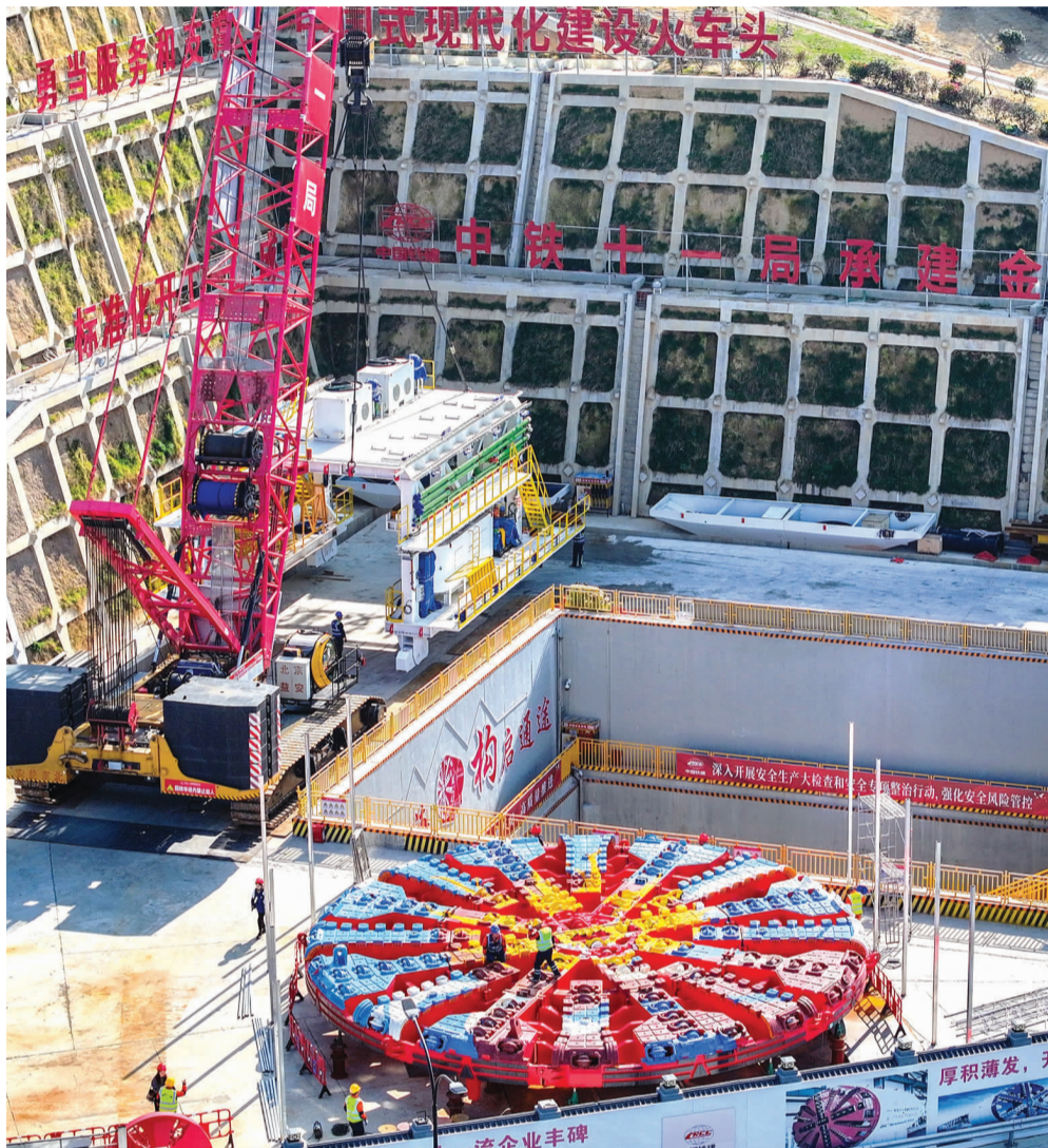
昨天,中铁十一局甬舟铁路3工区项目部的建设者们正在吊装盾构设备,为盾构机下井作准备 通讯员 姚峰 摄
