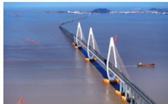
近日,舟岱大桥非通航孔桥两边的橙黄色浮格格外醒目。这是浙江交通集团投资建设的非通航防撞系统,采用“物理拦截设施+水上监控预警系统”组合设计,为舟岱大桥提供安全保障。
