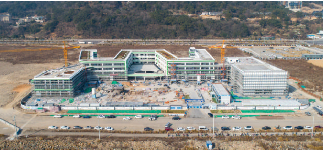
近日,东港新建小学项目建设转入室内装修及室外附属施工阶段,预计今年月底完工。东港新建小学总建筑面积 平方米,办学规模 班,投用后将作为普陀小学分校,缓解东港区块上学压力。 摄影 通讯员 蒲斌军
