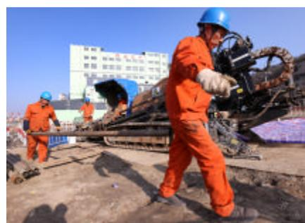
1月4日,舟山远洋渔业公共服务码头进港航道的岸边,一条10千伏陆上电缆在牵引机的作用下,穿过海床以下7米深的预置通道从1千米外的上园山岛登陆西码头岸边。全国首个陆缆穿海工程顺利完成电缆敷设。图/姚峰
