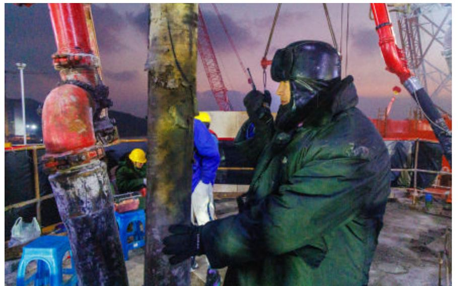
1月7日,西堠门公铁两用大桥5号主塔墩18根6.3米钻孔桩混凝土全部灌注完成,大桥建设取得阶段性进展。建设现场风力强劲,晚上温度更是接近0℃,施工人员坚守在一线。图/陈炳群
