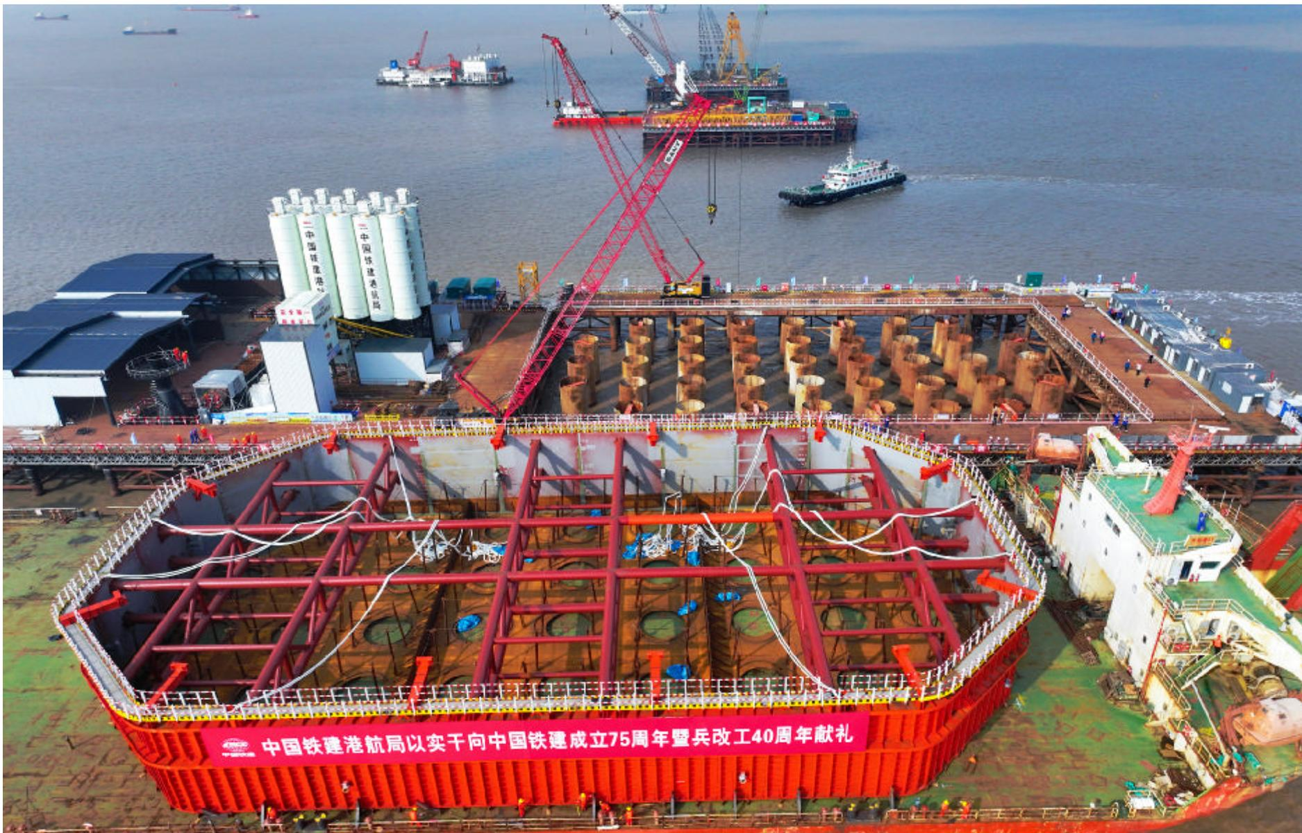
1月7日下午,重达1050吨的钢套箱在浮吊的作用下,顺利吊装到世界最大跨度三塔钢箱梁斜拉桥——青龙门大桥Q5主墩位置。这是青龙门大桥首个主墩钢套箱完成下放,标志着青龙门大桥正式进入海上主墩承台施工阶段。图/姚峰
