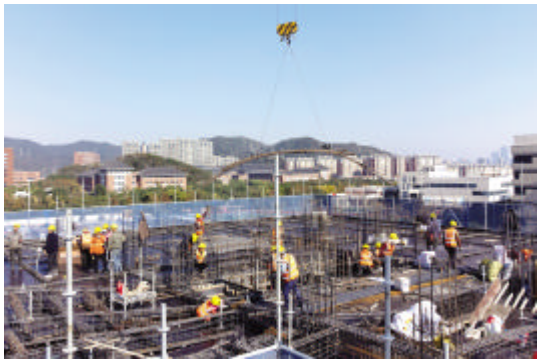
12月1日,东海实验室(智慧海洋实验室)总部产业园区一期工程现场,建设场面热火朝天 图/姚凯乐
