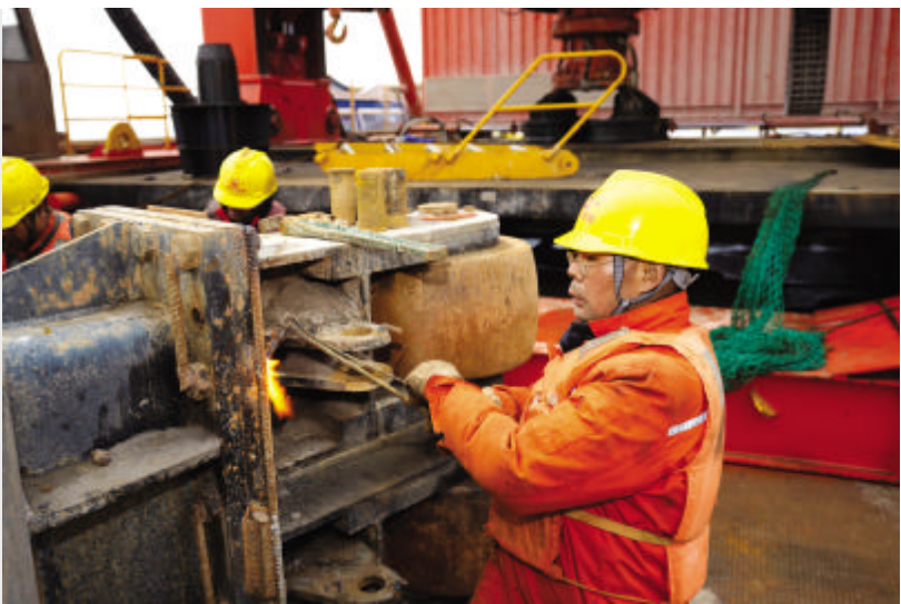
12月2日,甬舟铁路西堠门公铁两用大桥建设现场,建设者们开足马力,抓紧施工 图/姚凯乐
