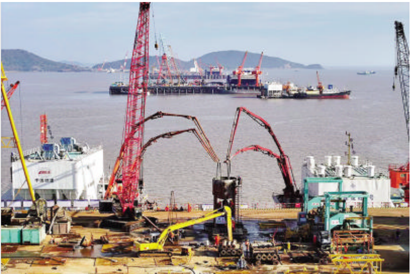
12月14日下午,六横公路大桥二期工程青龙门特大桥Q5号主墩桩基最后一根钻孔灌注桩浇筑完毕,Q5号主墩41根大直径变截面超深钻孔灌注桩全部浇筑完成,标志着青龙门特大桥首个主墩桩基完成浇筑施工 图/姚峰
