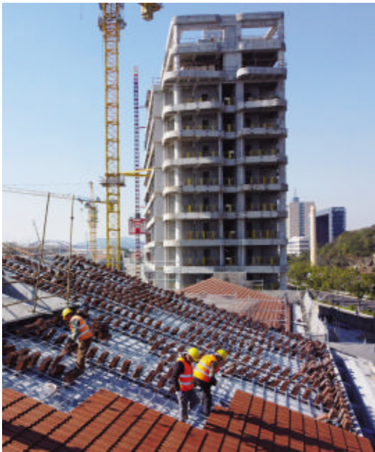
12月1日,新城欢乐海湾项目b地块,工人们在铺装房瓦 图/姚凯乐
