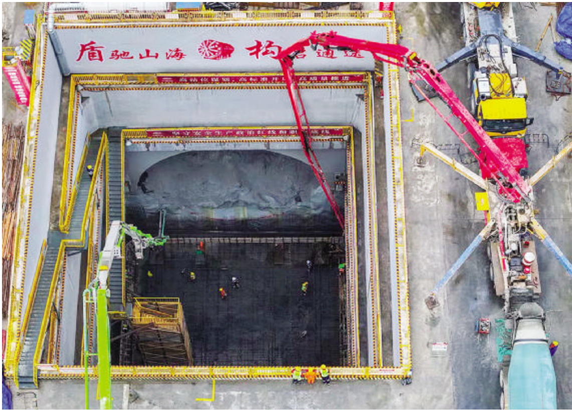
12月11日晚,随着最后一方混凝土浇筑完成,甬舟铁路金塘海底隧道舟山侧工作井底板顺利完成封底 图/姚峰
