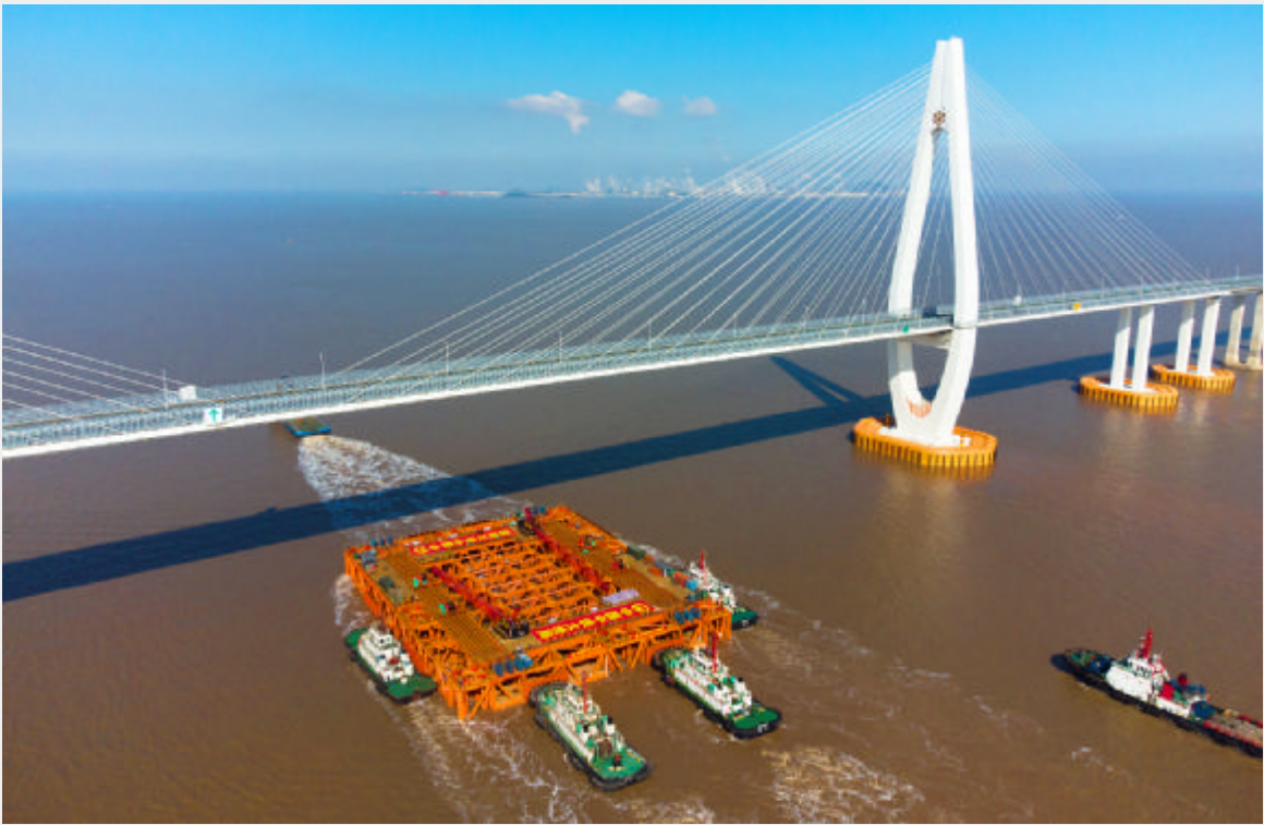
2月16日,甬舟铁路西堠门公铁大桥5号墩自浮式钻孔平台通过舟岱大桥主通航孔(无人机照片) 新华社发
