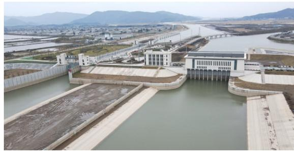
这是12月16日拍摄的引江济淮枞阳泵站(无人机照片)。当日,坐落在安徽省南部的引江济淮枞阳泵站启动3台大型水泵,中央控制室的大屏幕上显示,每台水泵正在以每秒约33立方米的流量将长江水引入河道,标志着引江济淮一期工程安徽段正式开启试调水。引江济淮工程是中国172项节水供水重大水利工程之一,集供水、航运、生态等功能于一身。工程以城乡供水和发展江淮航运为主,结合农业灌溉补水、改善巢湖及淮河水生态环境、排涝等综合利用,是跨流域、跨省的重大战略性水资源配置工程。
