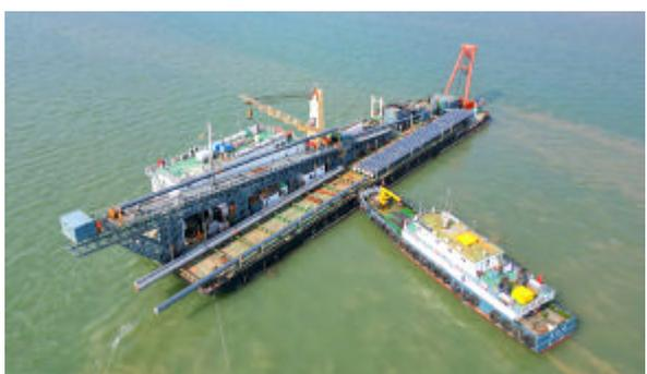
有限公司相关负责人李俊告诉记者,为避免铺管船只对金塘与镇海间海底原有管线造成影响,施工期间施工方升级了锚泊系统,使用多点锚泊避开相关区域,高质量地
