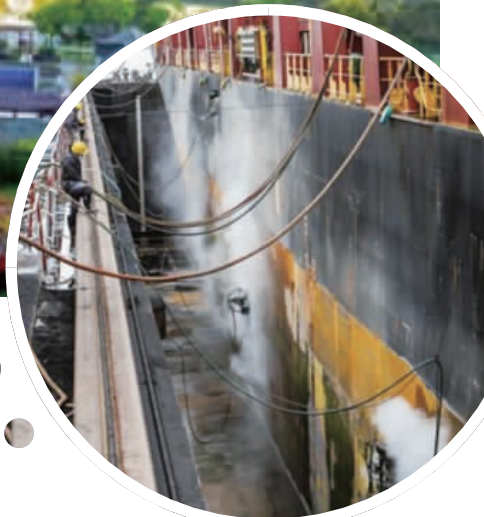
▲定海区爬壁机器人+超高压水除锈工艺
