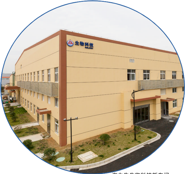
海力生生物科技新车间
