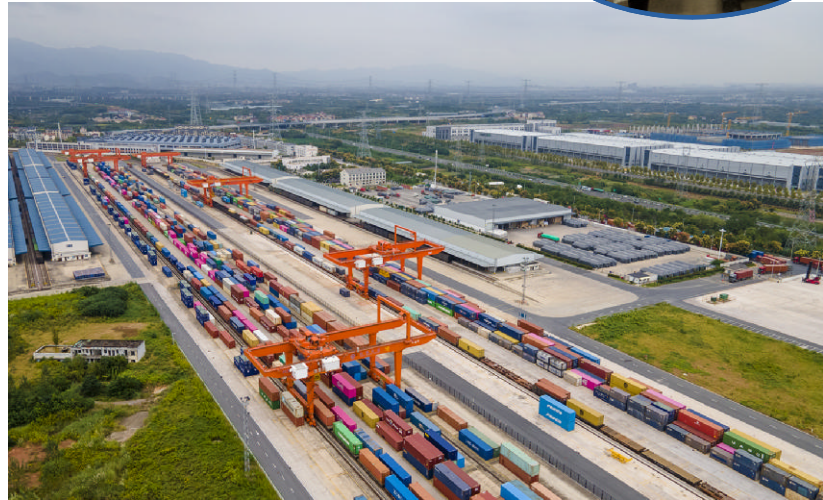
金华市金东区华东国际联运港
