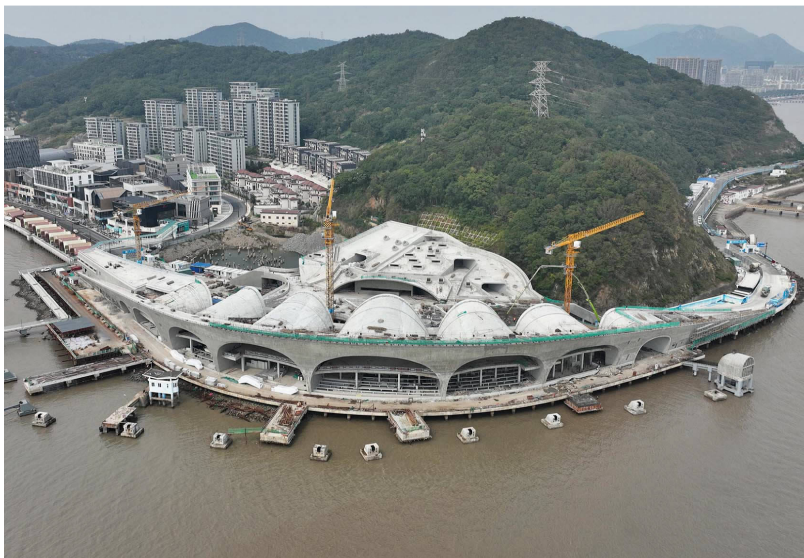
航拍器下,建设中的东港(半升洞)客运站场及城市广场建设工程主体建筑形如砬砬,蔚为壮观。目前,该项目已进入内外建筑装修阶段。据了解,该工程总建筑面积为42328平方米,预计于2024年5月竣工。 记者 陈永建 摄
