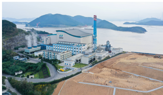
团鸡山生活垃圾填埋场综合治理项目
