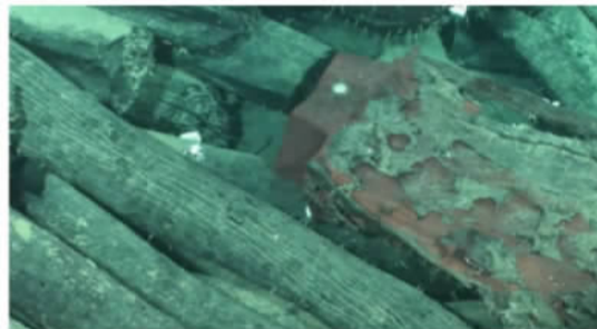
二号沉船被蛀蚀的船体构件
