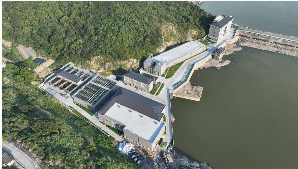
嵊泗县菜园镇海水淡化厂即将迎来投用。据了解，该项目为嵊泗县重大建设项目，工程总投资约1.73亿元。该工程将作为泗礁岛供水的主水源，承接大陆引水、海水淡化、水库制水三大功能。 记者 陈永建 摄
