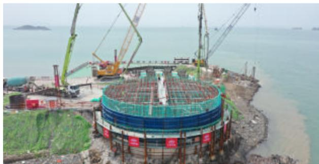
承台为双屿门通航孔桥右幅承台第一层,设计混凝土方量1592立方米,耗时12小时完成浇筑。单个承台及塔座分3
