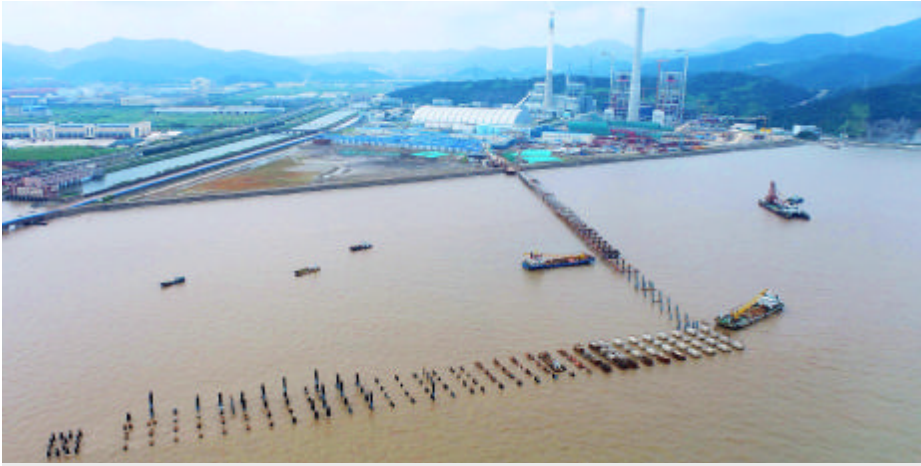
国能舟山电厂三期扩建项目码头工程完成海上全部桩基施工 摄影 记者 陈永建
