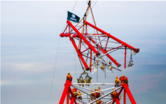
380米世界最高跨海输电高塔组塔 本版图片由国网舟山供电公司提供
