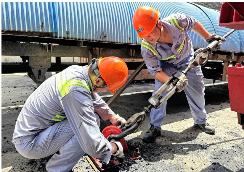
舟山港综合保税区码头有限公司组织工人开展门座式起重机防风锚定工作,全力防御台风“卡努” 记者 陈永建 通讯员 陈谦益 摄
