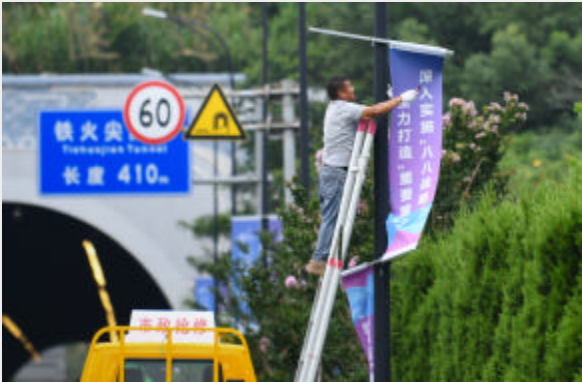
昨天，新城铁火尖隧道外，市政部门工作人员正在拆卸公路边的公益广告牌 摄影 记者 姚凯乐
