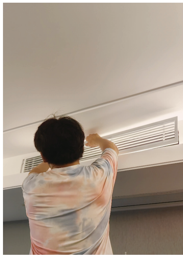
陈师傅在客户家清洗中央空调
