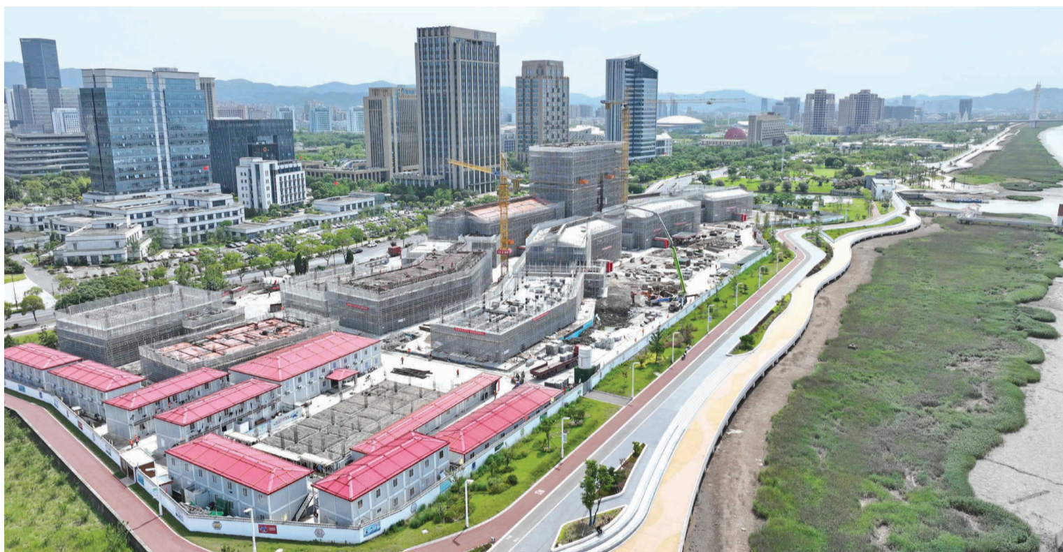
近日,在新城滨海城市带“欢乐海湾”项目-B地块,200名建设者正在加快施工。目前,该项目已完成总工程量的60%。该地块建设规模为44699平方米,共有9幢建筑,将打造成集文旅、休闲、餐饮、酒店于一体的滨海商业综合体。 记者 陈永建 摄
