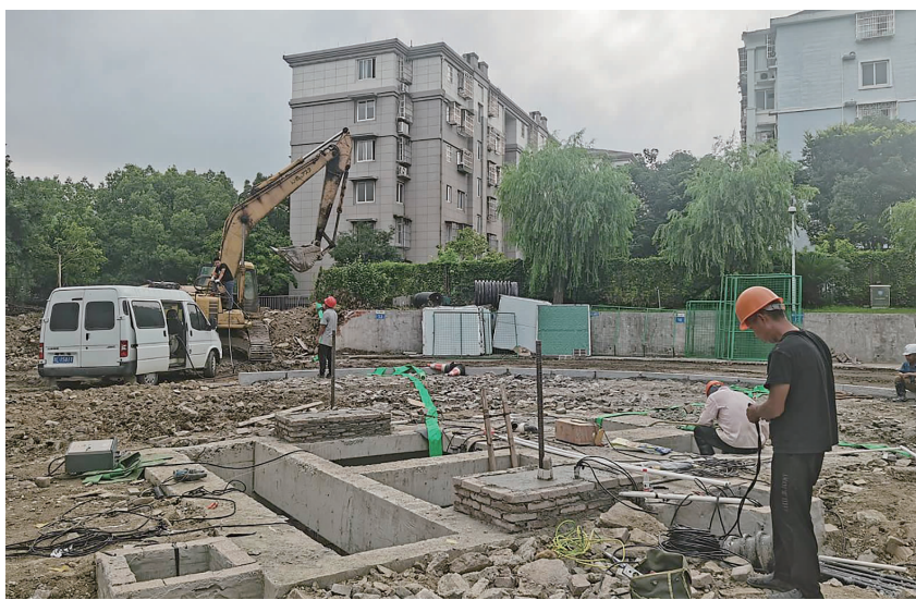
城市新境小区施工现场
