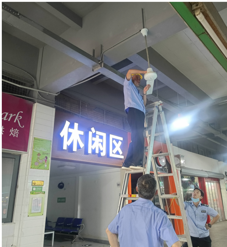
北门菜场工作人员正在安装电风扇
