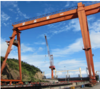
龙山船厂于1998年投用的32吨龙门吊，高度38米，跨度48米，为当时华东最大的龙门吊（摄于2003年）
