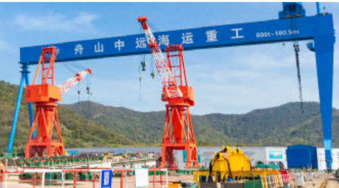
中远海运重工目前仍在使用的600吨龙门吊，高度97米，跨度181米（摄于2023年）
